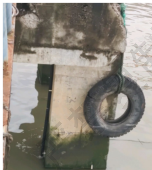
初期雨水排放管
