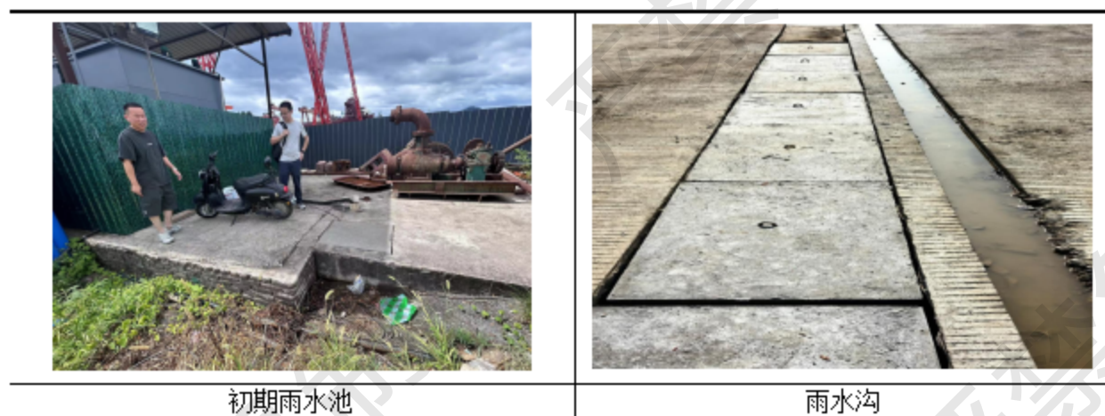
图 2.3-3 现有项目废水环保设施
